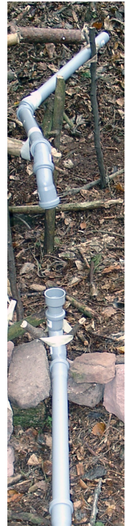
Abb.: Pipeline-Konstruktionen, Unterbauten und eine Alternative aus Plastikrohr.
